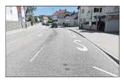
Die Haunwöhrer Straße im Abschnitt von der Eigenheimstraße bis zur Hagauer Stra-Be wurde 2010 mit einem lärmoptimierten Asphaltbelag ausgestattet. Nach starker Verkehrsbelastung zeigt sich insbesondere in den Einmündungsbereichen und Fahrspuren ein deutlicher Verschleiß und eine bausubstanzerhaltende Deckensanierung muss durchgeführt werden. Mitte Mai wird die Straße deshalb für wenige Tage voll gesperrt. Kosten: rund 300000 Euro. Foto: Tiefbauamt
