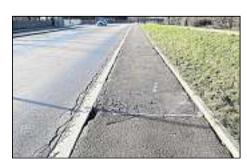
Der 1966 hergestellte Rad- und Gehweg an der Peisserstraße zeigt alterungsbedingte Schäden. Für die Radfahrer ist diese Situation eher unkomfortabel. Weil aufgrund des Gesamtzustandes mit kleinflächigen Reparaturen keine wesentliche und dauerhafte Verbesserung der Situation erzielt werden kann, werden die Geh- und Radwege erneuert. Außerdem wird eine Bushaltestelle barrierefrei umgebaut. Die Projektkosten betragen rund 510000 Eu-
