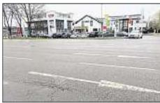
Die Manchinger Straße von der Kaserneneinfahrt bis zur Schütterlettenstraße weist einige Schäden (starke Spurrinnen, Risse, Substanzverlust) auf und muss erneuert werden. Für 490 000 Euro wird deshalb eine neue Asphaltdeckschicht aufgetragen. Die bauliche Umsetzung erfolgt in mehreren Phasen unter Teilsperrungen, allerdings nicht zum Ferienverkehr auf der Autobahn und an Heimspielterminen des FC Ingolstadt. Umleitungen werden eingerichtet. Foto: Tiefbauamt
