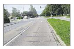
Die Maximilianstraße/Am Pulverl braucht substanzsichernde Sanierungsmaßnahmen, um Rissen, Flickstellen und Setzungen sowie Problemen mit der Straßenentwässerung entgegenzuwirken. Bohrkernuntersuchungen haben zudem ergeben, dass auch die darunterliegenden bituminösen Tragschichten beschädigt sind. Anfang bis Ende Juli werden die Bushaltestellen umgebaut, anschließend folgen Anfang August die neuen Asphaltschichten. Foto: Tiefbauamt
